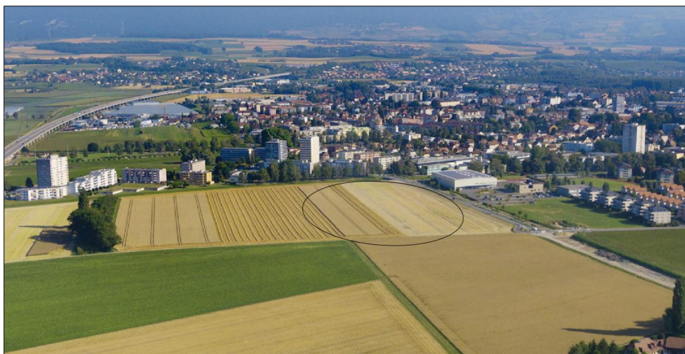
Figure 8 : Vue aérienne de la limite actuelle de l'urbanisation. Source : www.aggloy.ch
